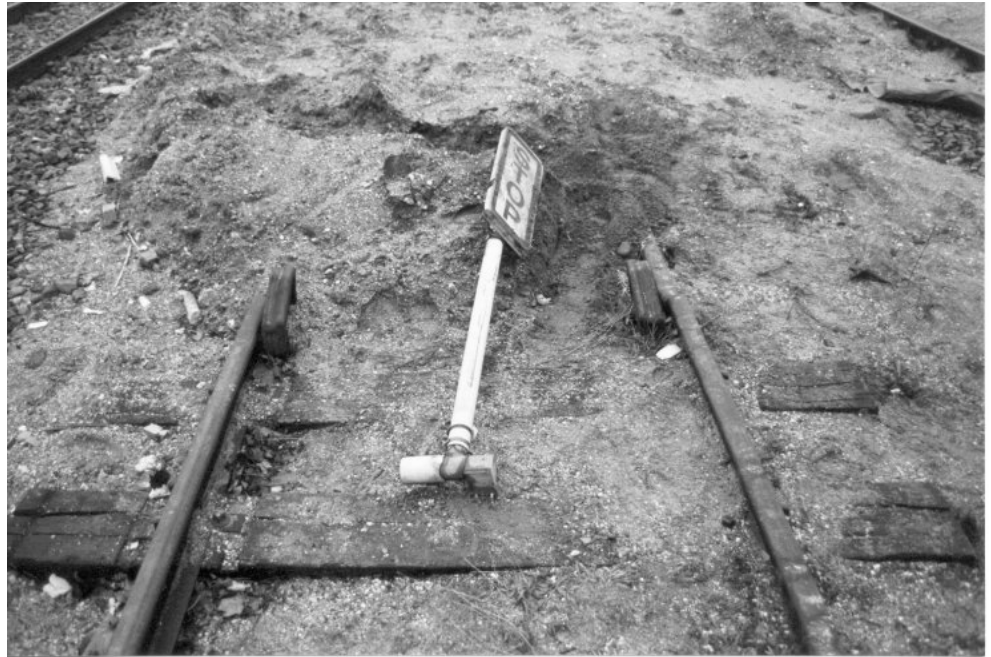
Enden af Holte spor 21 med mærke "stop" og sporstopper.
